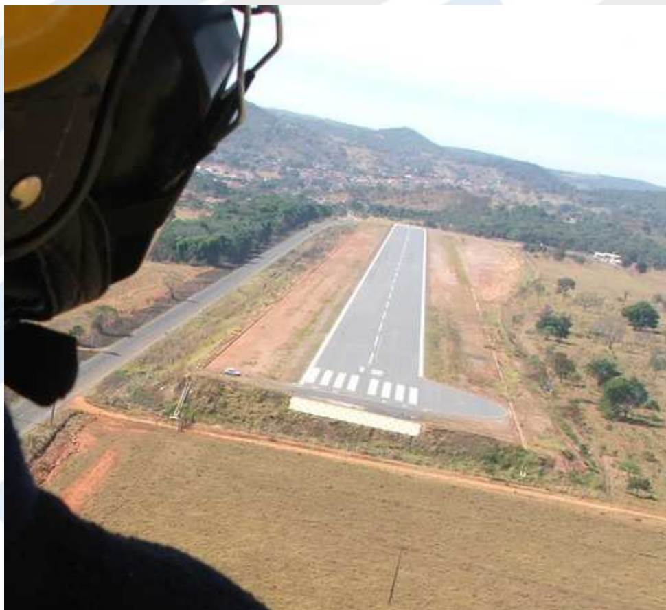
Figura 8 - Vista aerea do Aeroporto de Pirenópolis
