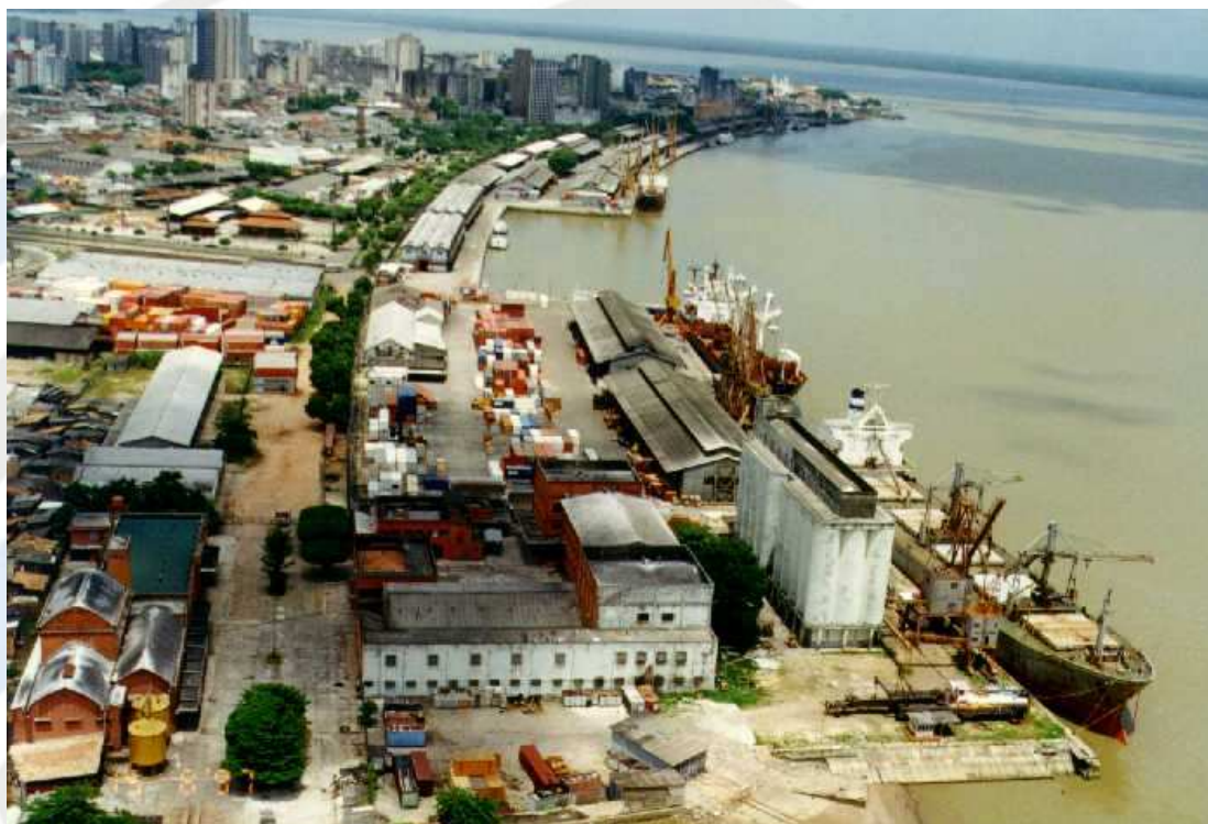
Figura 14 - Vista aerea do Porto de Belém - PA
