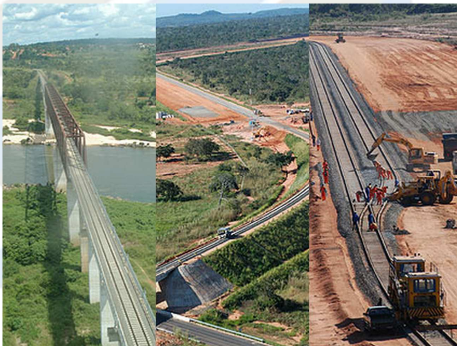
Figura 10 - Obras da Ferrovia Norte-Sul
