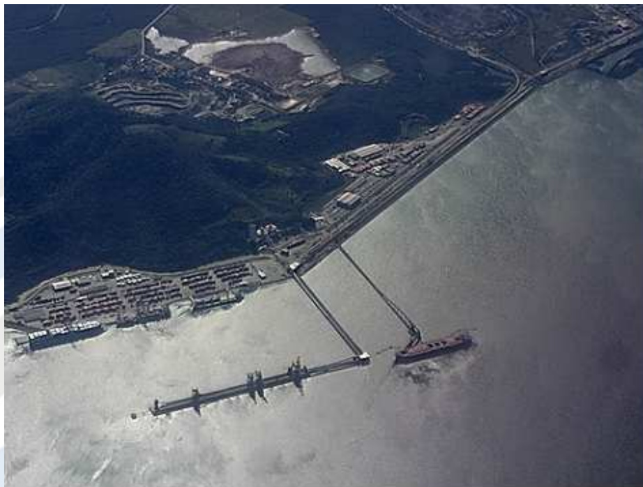
Figura 16 - Vista Parcial do Porto de Itaguai
